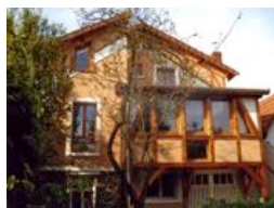
Surélévation d'un pavillon de banlieue. Cabinet : Naumovic JM.
