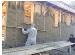
Chantier D. Bayol
