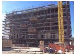
Chantier Italien de 61 logements avec enveloppe en béton de chanvre.
