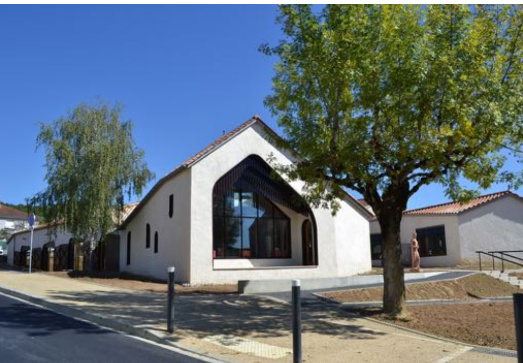
Pôle socioculturel du quartier de Gour de l'Arche, Périgueux. Cabinet d'architecture : Dauphins.
