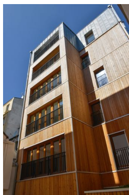
Projet rue Myrha de NXNW, et LM ingénieur. Crédit photo : Franck Renoir. Béton de chanvre à 330kg/m 3 .
