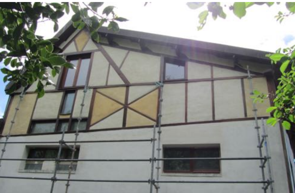
Surélévation d'un pavillon de banlieue parisienne, façade est. Architecte : J-M Naumovic.
