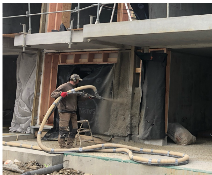
Photo 2 : Exemple de projection mécanique de béton de chanvre sur un coffrage perdu intérieur en plaque de gypse.
