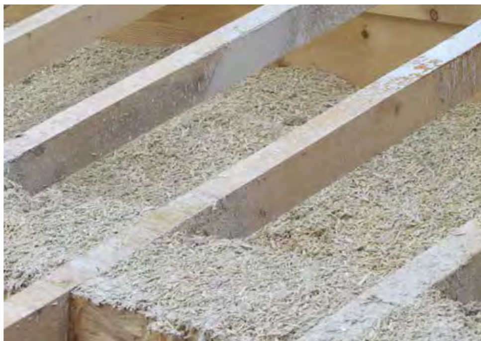
Béton de chanvre mis en œuvre en toiture
