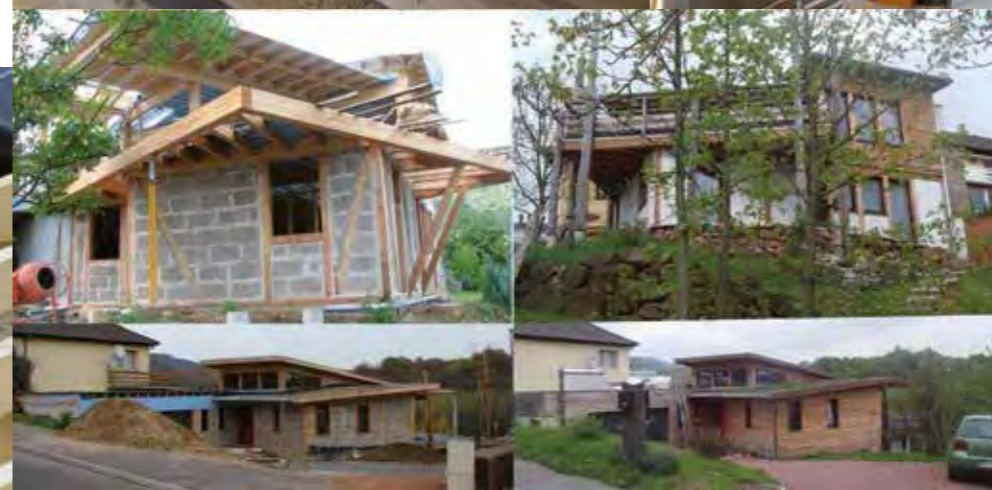
Chantier en blocs à maçonner
