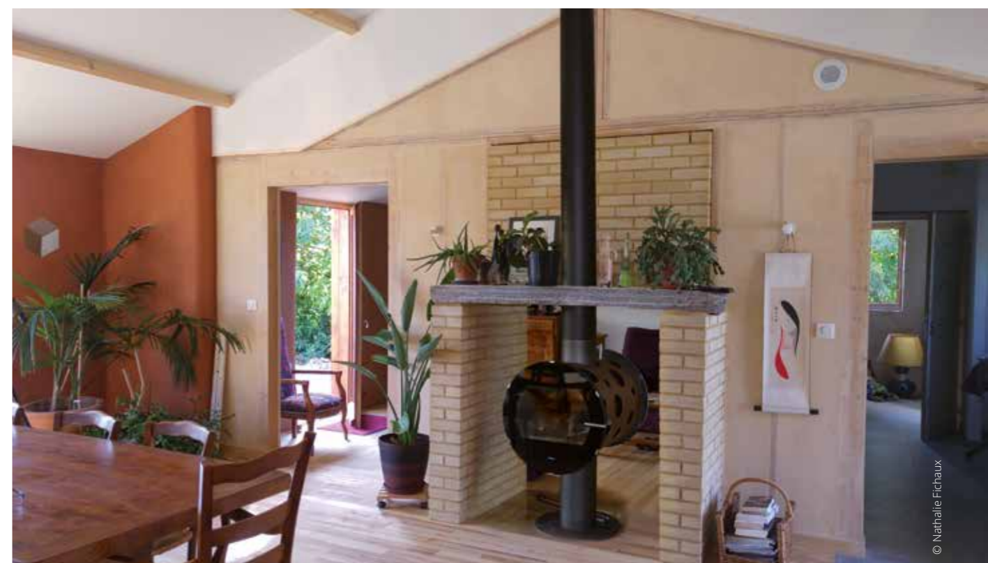
Inertie intérieure complémentaire apportée par les briques de terre crue entourant le poêle.
