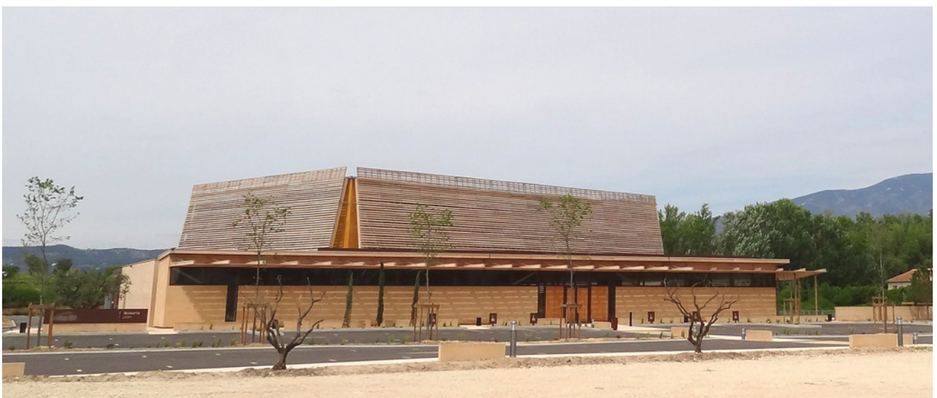
© Communauté de Communes Vallée des Baux-Alpilles – Siège de la CCVBA – Saint-Rémy-de-Provence (13)
